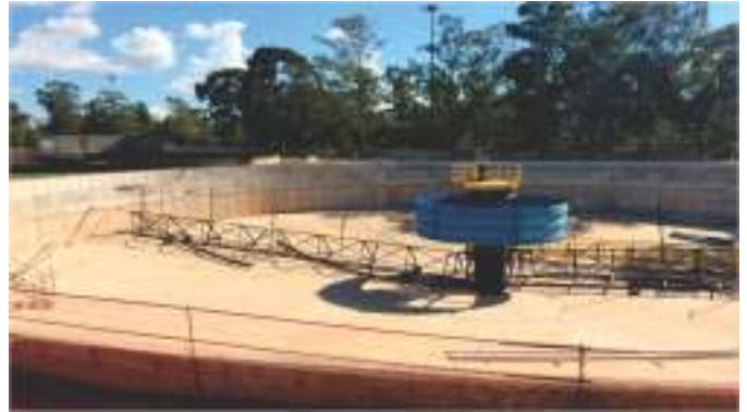
Decantador Primário ETE Barueri - São Paulo, Brasil
