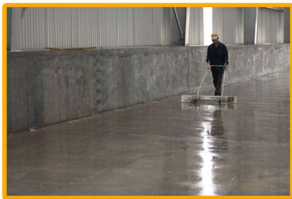
Espalhamento do PENESEAL FH em piso industrial. Fonte: Penetron Vietnã.
