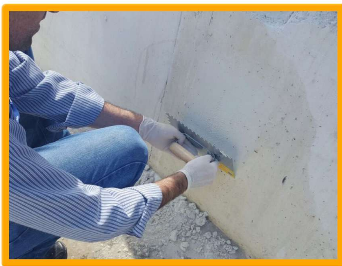
Estucamento com Patchline 3000 em superfície de concreto. Fonte: Penetron Brasil
