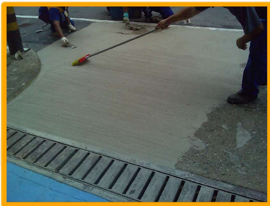
Aplicação de PENETRON CR90 em rampa de concreto. Fonte: Penetron Brasil.
