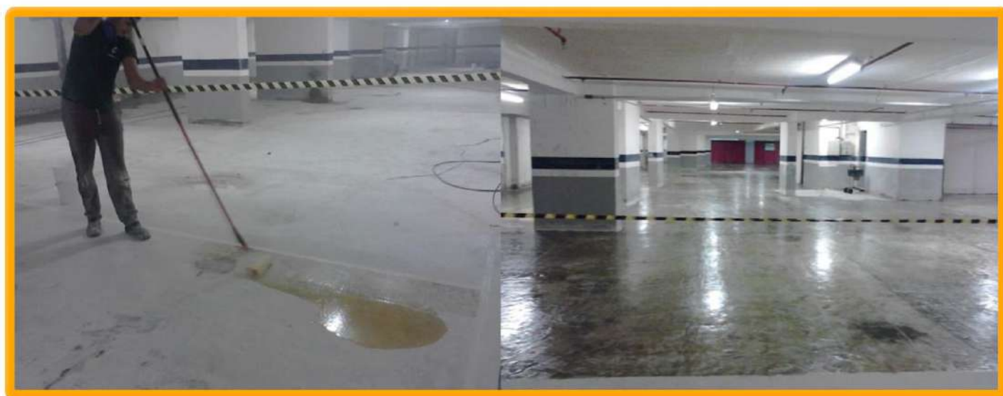
Aplicação do Penetron VB225 em laje de subpressão. Fonte: Penetron Brasil.
