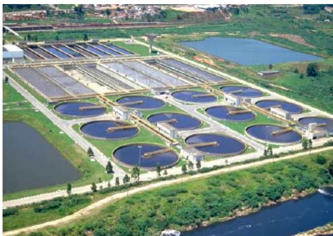
ETE Baruei da Sabesp com PENETRON BIOMIC
